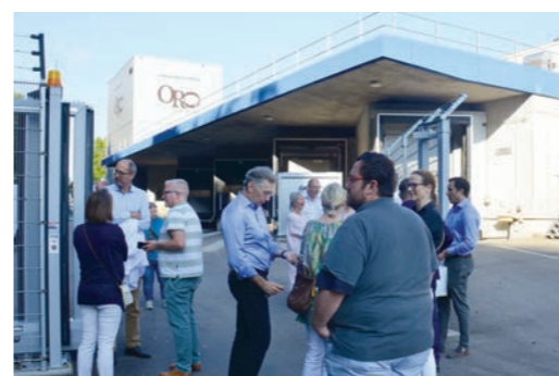
Oro de Cacao hat ein altes Gebäude komplett saniert und dort seine hochmodernen Produktionsanlagen installiert.
